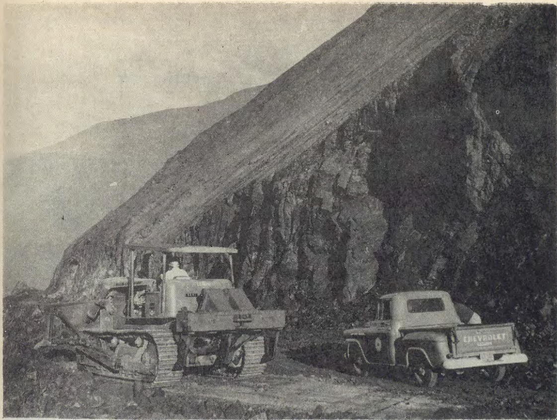
ENSANCHE DEL CAMINO. A lo largo del longitudinal Norte se trabaja activamente en obras de mejoramiento y construcción. Aparece aquí un tornapull trabajando en un corte de roca en la Quebrada de Camarones.
