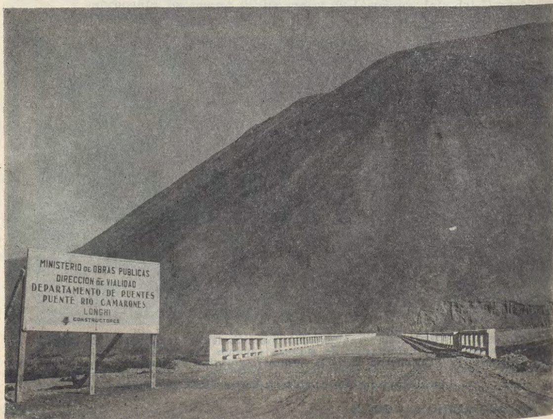
CONSTRUCCION TERMINADA. En uno de los extremos del puente, se encuentra el letrero del Ministerio de Obras Públicas, Dirección de Vialidad, Departamento de Puentes, Puente Rio Camarones, Lonchi, Constructores, que señala la entrega de la obra al uso público.
