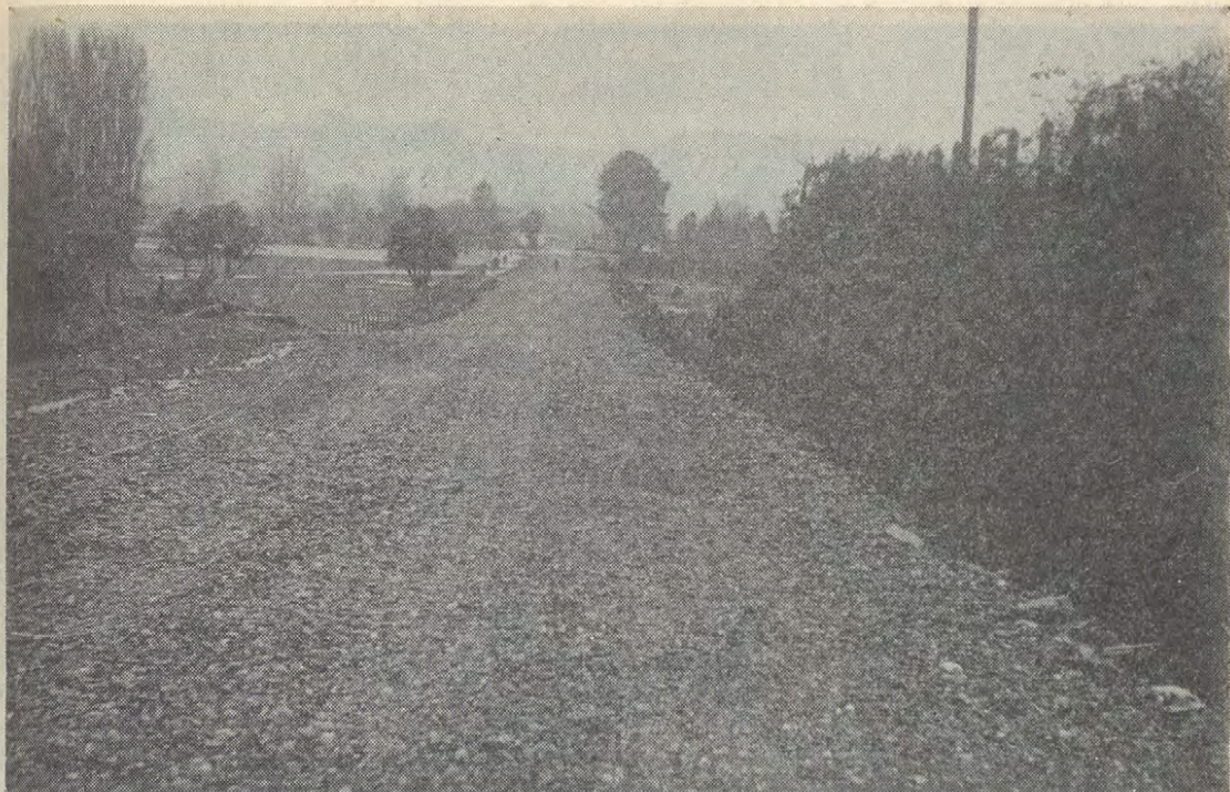
ACCESO AL AEROPUERTO. Las inundaciones bloquearon el acceso al aeropuerto de Las Marias. La Dirección de Vialidad habilitó este camino ripiado para mantener el servicio.
