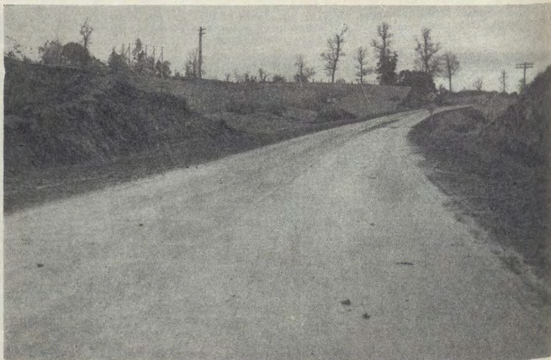
PAVIMENTOS DEL SUR. Un camino con pavimento de concreto, usual en la región, en los accesos a la localidad de San Pablo.
