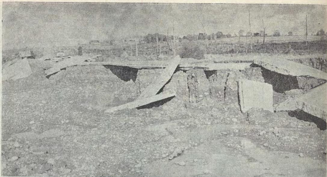
**COMO UN CASTILLO DE NAIPES** se desmoronó el camino pavimentado entre Puerto Montt y Puerto Varas. Es uno de los más extraños efectos causados por la ondulación sísmica del suelo.
