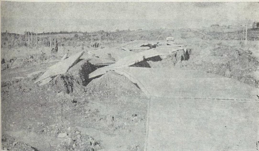
**ESTO ERA UN CAMINO.** Los extraños efectos del sismo ocasionaron destrucción como la que muestra la fotografía. Los hundimientos y levantamientos del suelo hicieron saltar las losas de concreto, volcándolas y dejándolas en la caprichosa disposición que puede apreciarse.
