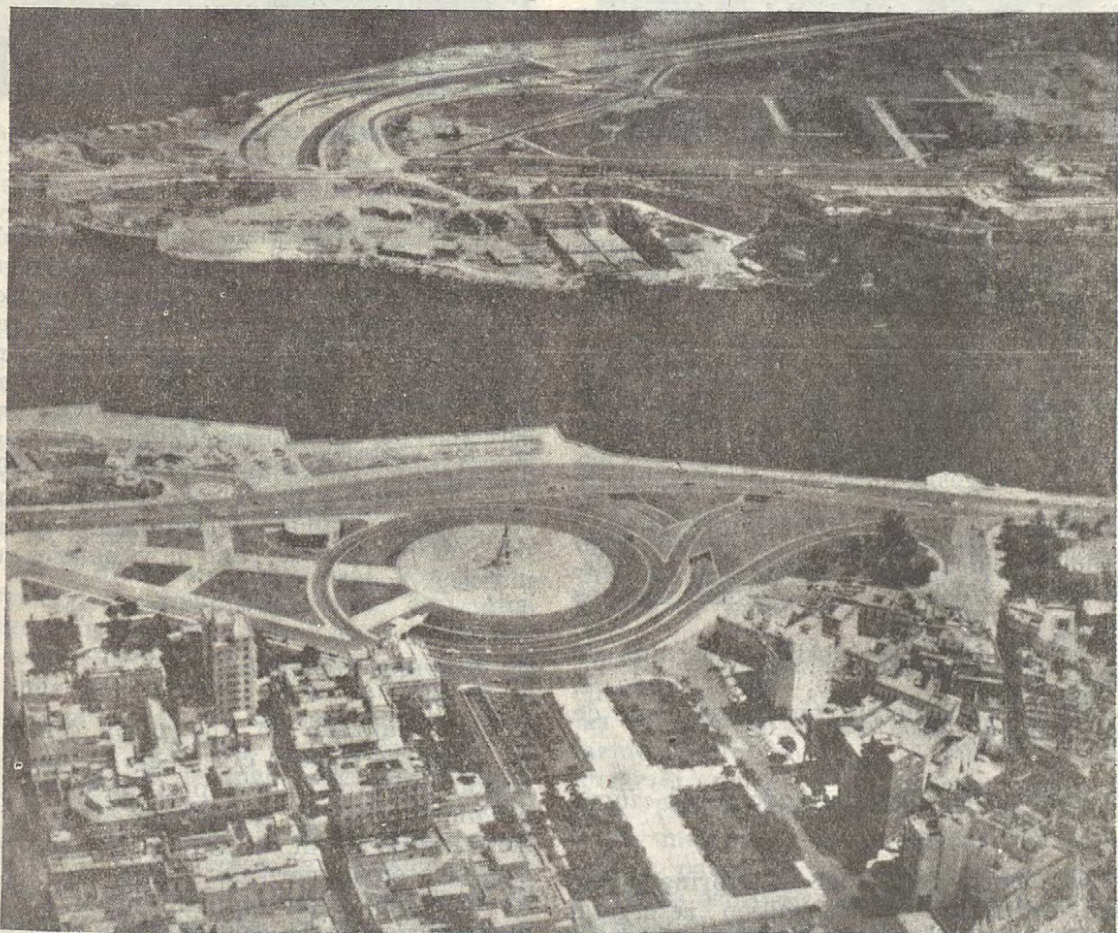
CONJUNTO DE OBRAS EJECUTADAS
