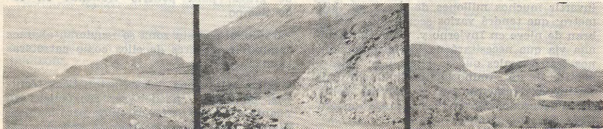
Tres vistas de las obras de construcción del camino de Río Blanco a Puerto Ibáñez en la Provincia de Aysen. Estos trabajos están a cargo de la firma Oscar Spichiger y Cia.
