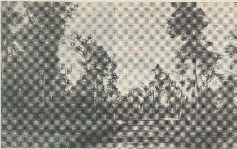
KM. 33,5. SECTOR FUNDO PUANCHO. Esta huella fué habilitada con motoniveladoras y buldozer D-4.
