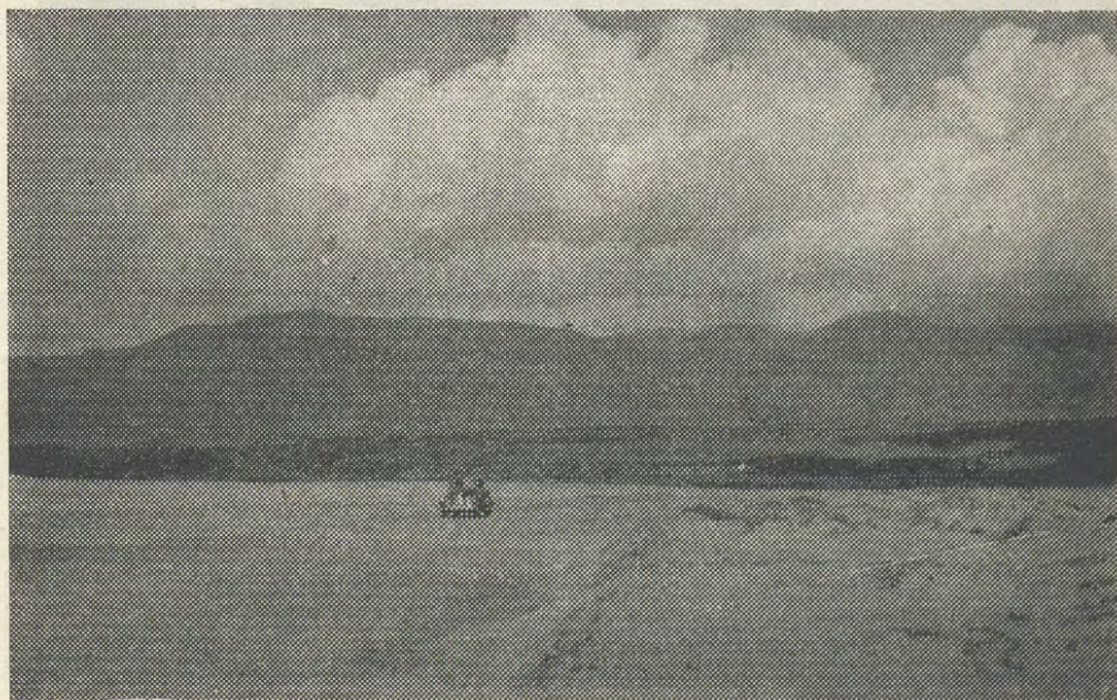
AGUA AMARILLA, KM. 227. PROVINCIA DE COQUIMBO. La carretera al Norte de Los Vilos debe cruzar un corto trayecto sobre las dunas de Agua Amarilla. El afirmado se ha asentado sobre una base de plantaciones de arbustos y de doca (algazul chilena).
