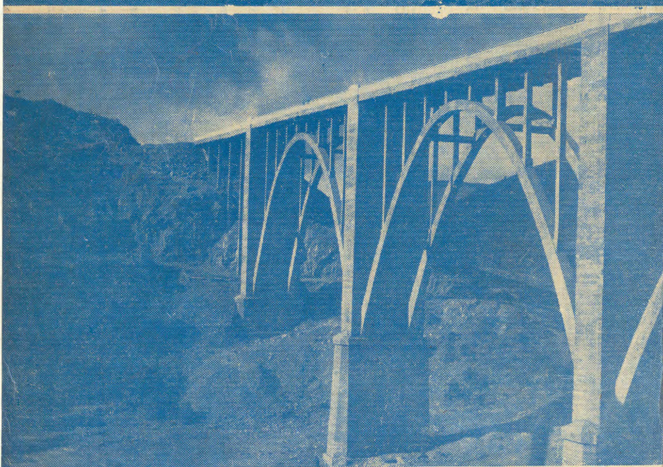
VIADUCTO AMOLANAS EN EL KM. 306 DE LA CARRETERA PANAMERICANA.— Obra de concreto armado de 240 m. de largo con calzada de 7 m. de ancho y pasillos laterales de 0,75 m. La calzada queda a 50 m. sobre el lecho de la Quebrada de Amolanas. Los arcos centrales tienen 48 m. de luz cada uno. Proyecto del ingeniero Oscar Jiménez Gundián.
