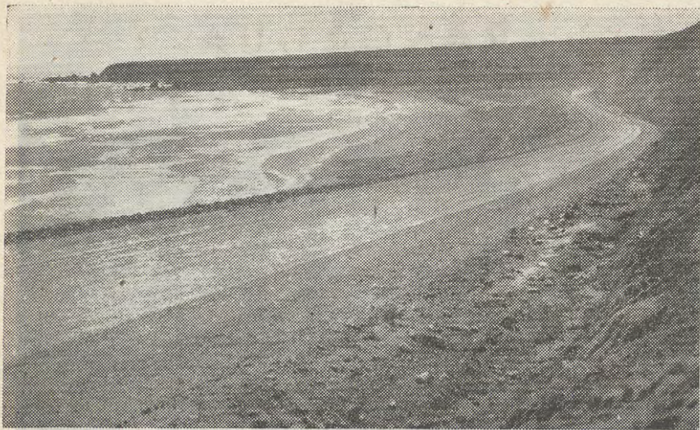
BAHIA PLAYA AMARILLA, KM. 240. PROVINCIA DE COQUIMBO. La Carretera pasa por la orilla de esta hermosa playa. La base estabilizada está lista para recibir el pavimento superior definitivo.
