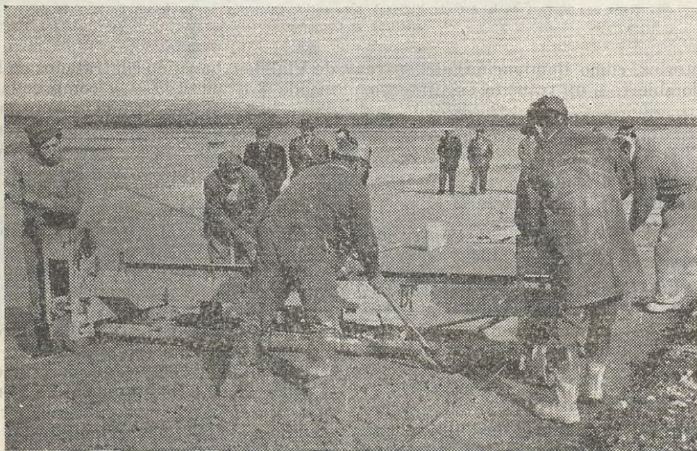
AERODROMO DE CHABUNCO. Faenas de pavimentación efectuadas por la firma contratista Carlos Longhi y Cía. Ltda. En la fotografía, de abrigo negro inmediatamente tras los obreros el Sr. Carlos Longhi y de boina negra el Director de Vialidad don Eduardo Paredes, acompañado del Comandante de la Base Aérea de Punta Arenas, en una visita efectuada en el presente año a esas faenas.
