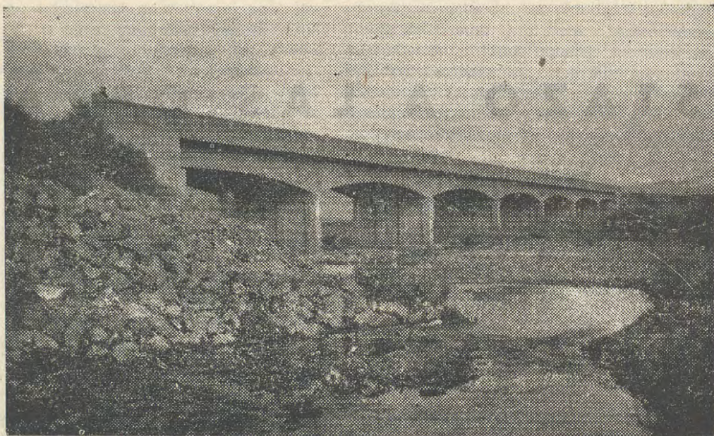
PUENTE ACONCAGUA, KM. 100, PROVINCIA DE VALPARAISO. Esta obra se construyó frente a Ocoa y a la Puntilla de Torrejón. Es de concreto armado, longitud 170 m., calzada de 7 m. de ancho y pasillos para peatones de 0,75 m.
