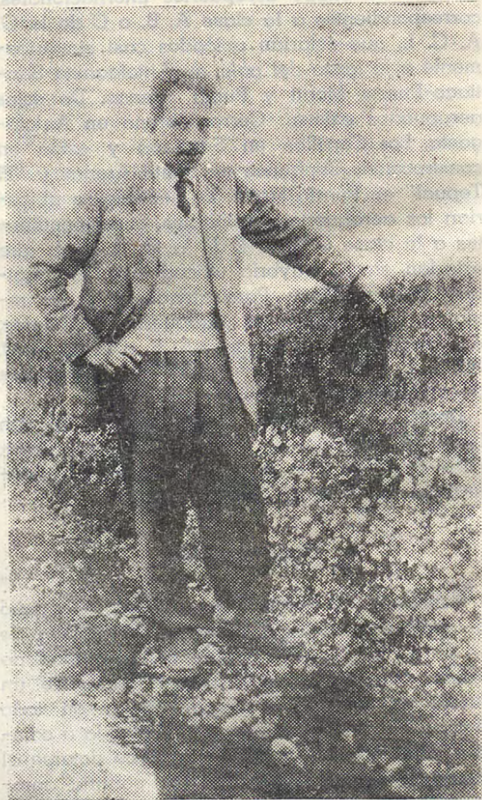
En la fotografía, el Ingeniero de la Provincia de Llanquihue, don Luis Alberto Plaza, muestra las diferentes capas del terreno donde se construirá el Aeródromo de El Tepual. Esta zanja se excavó perpendicularmente al eje de la cancha para hacer escurrir las aguas a un estero cercano.
