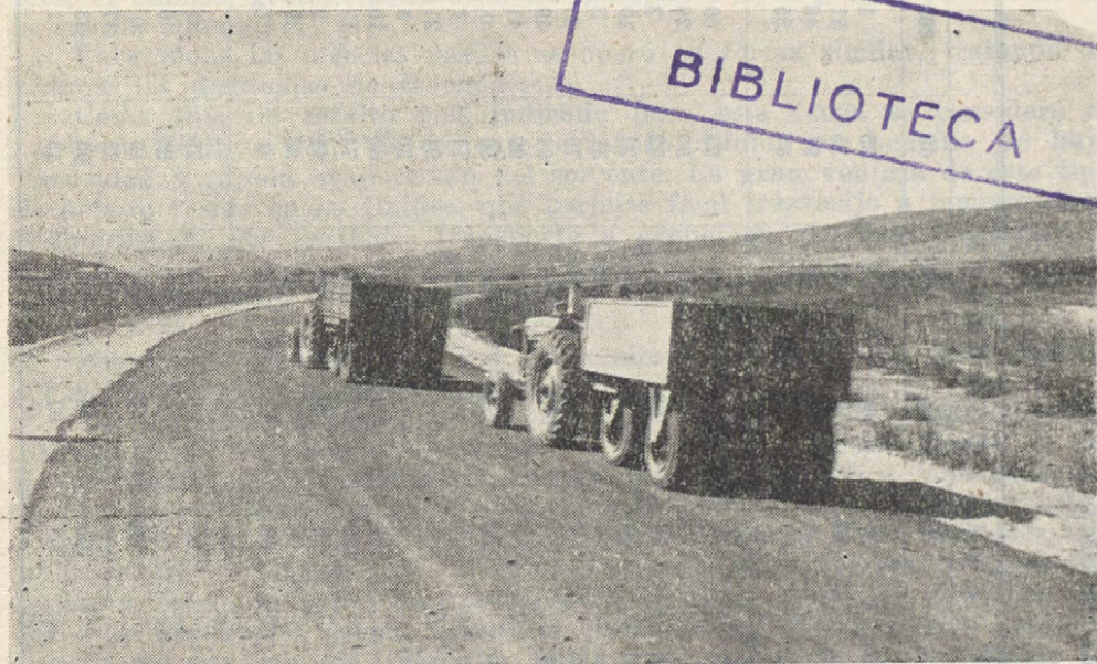
Rodillos neumáticos remolcados por tractores consolidan la base estabilizada asfáltica.
