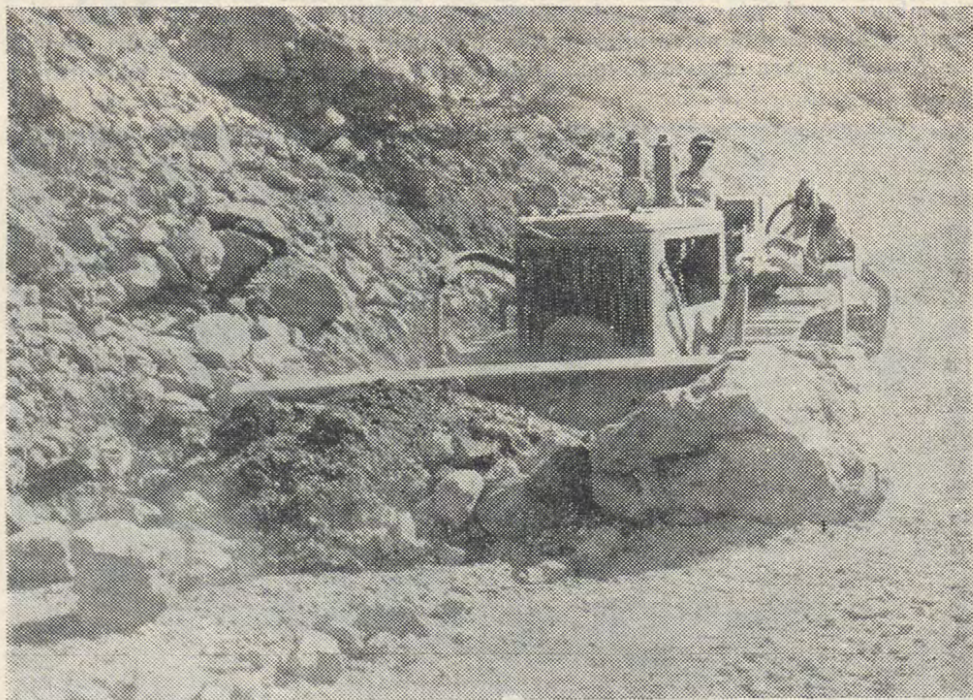
El Peñón Km. 49, tractor-oruga, con hoja de empuje, colabora en las obras de ensanche de este camino, que se mantiene pegado al río Colorado por lo escarpado de las faldas de las montañas que lo encajonan.
