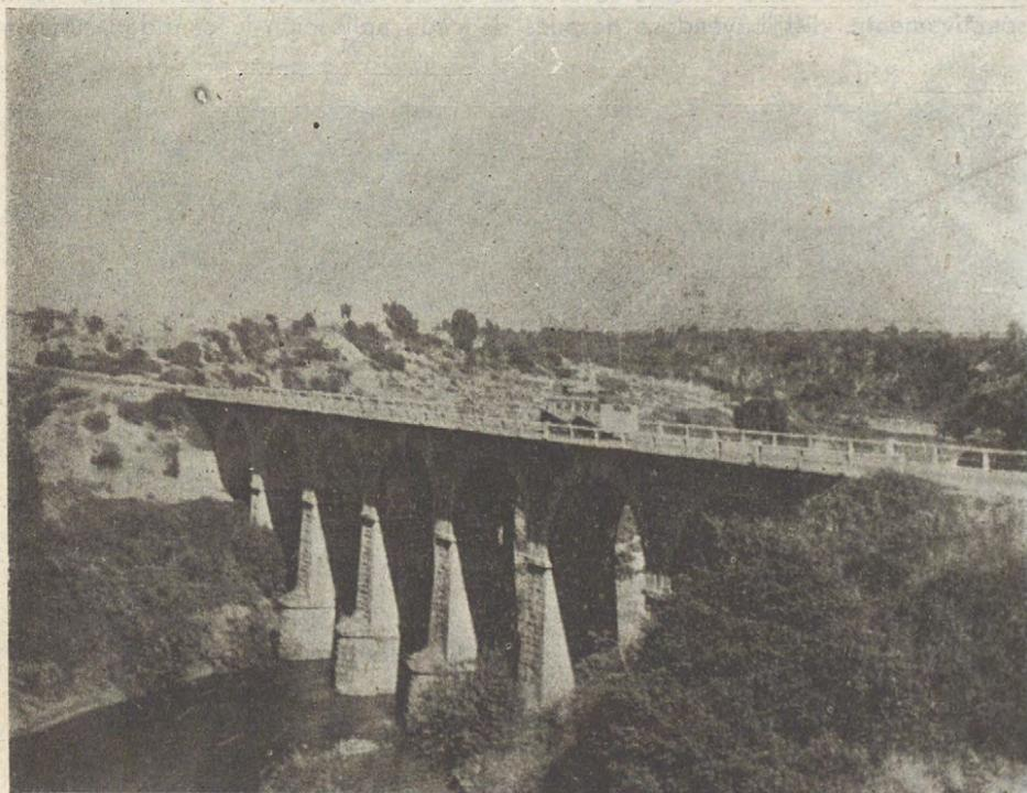
**PROVINCIA DE TALCA.** — Puente sobre el Río Claro. Este puente que está formado por arcos de manostería, que dan a su arquitectura una nota de singularidad fué antiguamente puente ferroviario. Se le acondicionó previo ensanche una calzada de concreto armado de 7 m. con pasillos laterales para peatones de 0.70 m. y tiene un largo de 118,3 metros.
