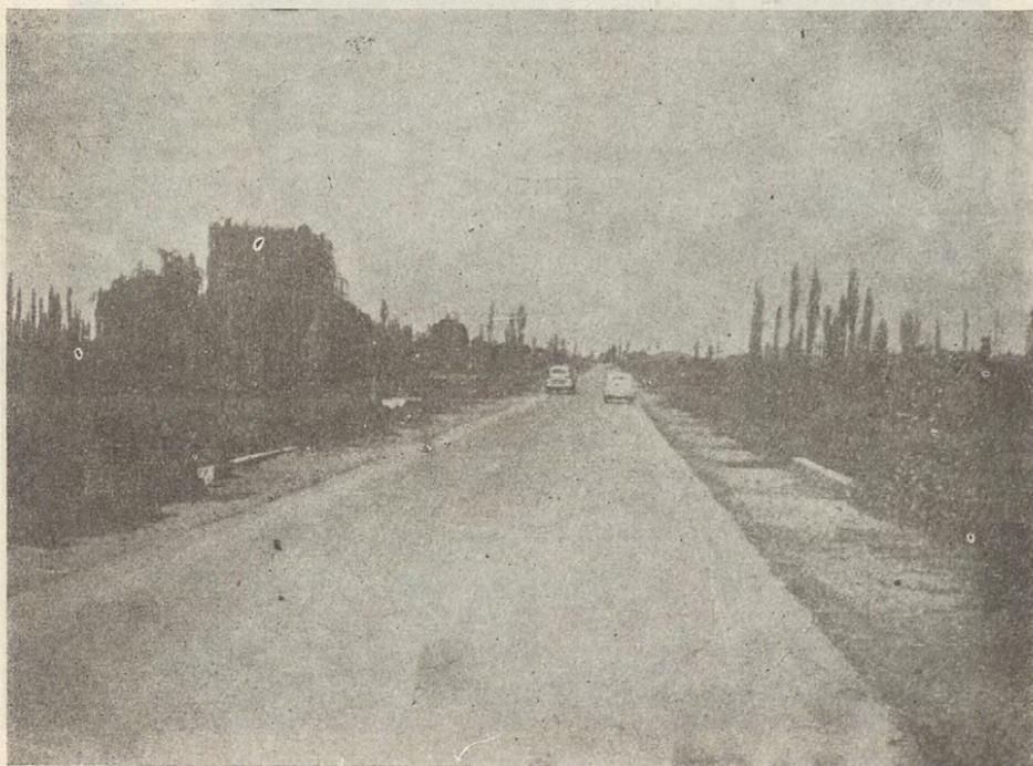
PROVINCIA DE LINARES.— Calzada de macadam asfáltico recién entregada al tránsito, en el Km. 276. Aún falta rellenar las bermas, como puede apreciarse en los muros de la alcantarilla que la atraviesa. Contrato Talca-Putagán-Longavi.
