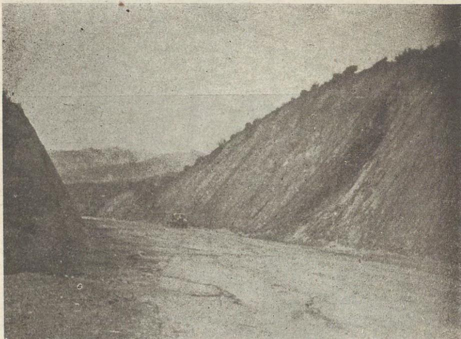
1. — Túnel. — Acceso Oriente al Túnel de Zapata, Km. 81,4. La fotografía muestra los grandes cortes que han dado motivo a la variante que une a Curacaví con el túnel.
