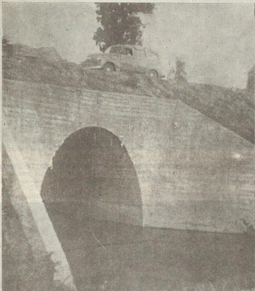
PROVINCIA DE LINARES. — Camino de San Javier a Villa Alegre. Bóveda de concreto sin armadura, de 4,8 m. de luz ubicada en el Km. 6. Con esta obra de arte se reemplazó un antiguo puente de madera.
