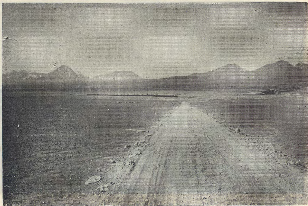
Camino de Toconao a Peine.— Huella de 3 m. de ancho.—Afirmado de grava sobre dunas a la llegada a Toconao.
