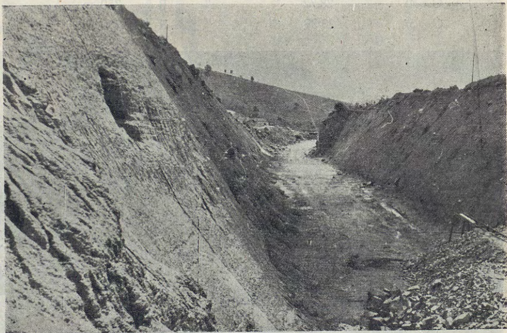
Camino de acceso occidental visto desde la boca del túnel. Estos grandes cortes empalman con el camino a Casablanca.
