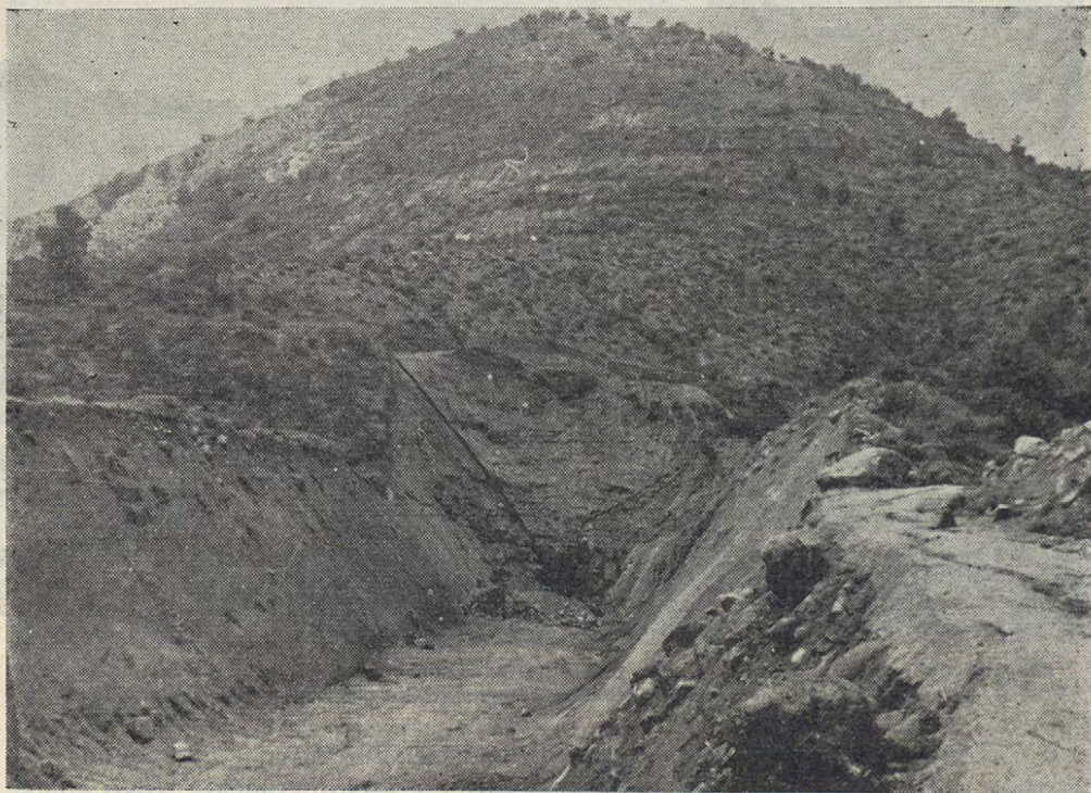
Camino de Acceso Occidental al Túnel. Se puede apreciar claramente la altura del cerro que dejará colgada esta obra. El portezuelo por donde pasa el camino actual es 160 metros más alto que la cota máxima del túnel.
