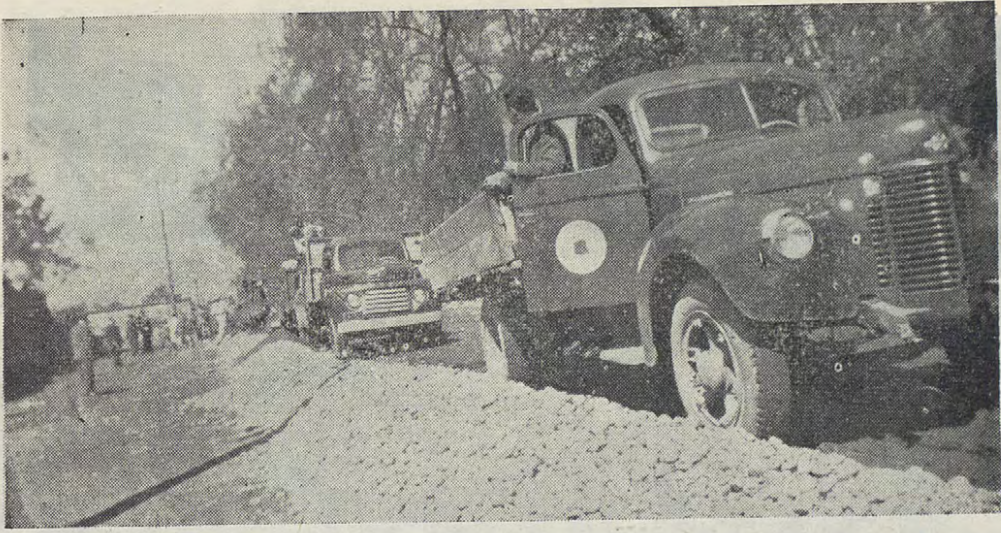
Camiones de Camincs en las faenas de estabilizadcs de la Alameda Yungay de San Felipe.
