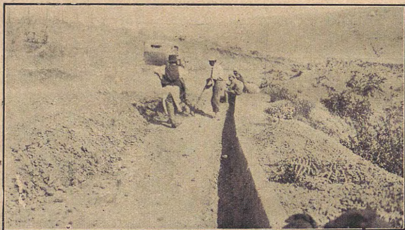
Camino de San Antonio a Cartagena.—El mismo terraplén después de diez inyecciones con lanza de agua.
