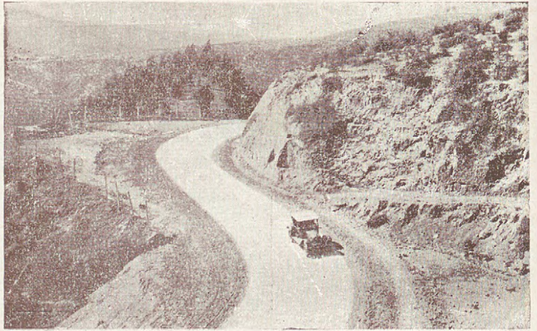
CAMINO DE VALPARAÍ- SO A CASABLANCA. PAVIMENTO DE CONCRETO ARMADO
