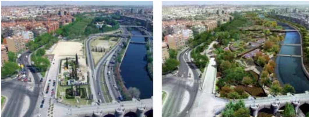
FIGURA 4.5 Autopista de Madrid M30: Antes-Después
