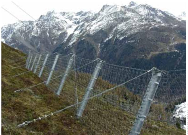
Las estructuras flexibles están constituidas por redes de alturas de entre 3 y 5 metros, generalmente de cable de acero con mallas triangulares o rectangulares, instaladas perpendicularmente a la pendiente en las zonas de generación de la avalancha.
