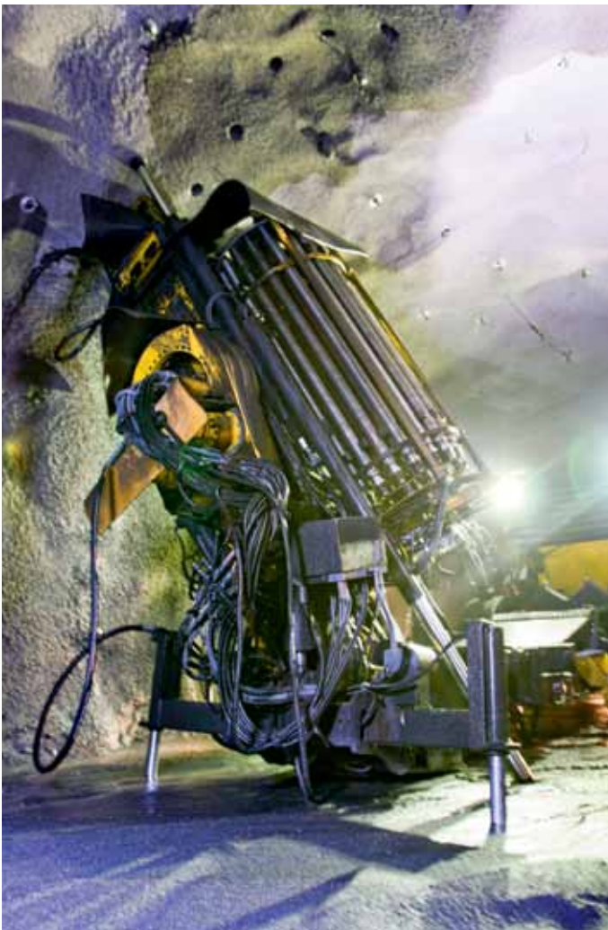
El Simba WL6 C en el modo de perforación “full fan”, perforando pozos de 30 m de largo en el centro del abanico y pozos de 17 m en los costados.
