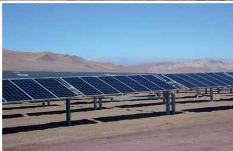
**El proyecto abarca una superficie de aproximadamente 215 hectáreas y cuenta con más de 300.000 módulos solares fotovoltaicos montados en seguidores solares de un eje SunEdison AP90.**
