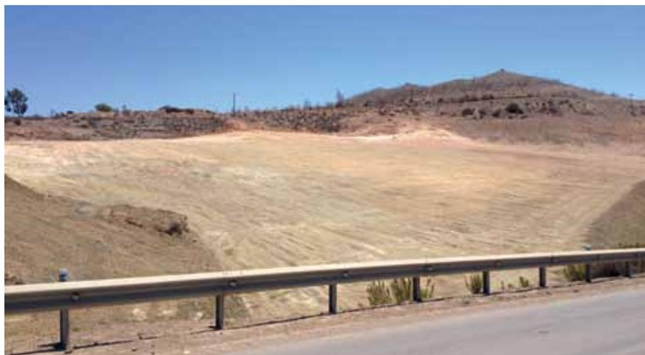
namiento del terreno, donde se realizaron obras civiles para nivelar la superficie del terreno. Luego, se fijaron los tornillos para sostener los módulos. Consecutivamente se instalaron las estructuras de soporte para éstos y finalmente se protegió el emplazamiento, construyendo un cierre perimetral.
