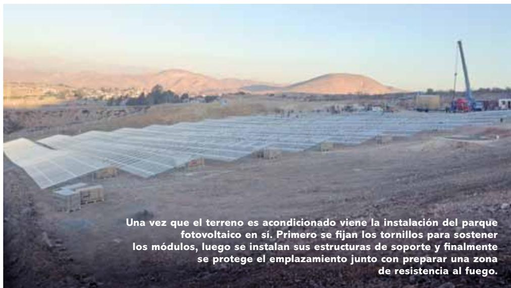
Una vez que el terreno es acondicionado viene la instalación del parque fotovoltaico en sí. Primero se fijan los tornillos para sostener los módulos, luego se instalan sus estructuras de soporte y finalmente se protege el emplazamiento junto con preparar una zona de resistencia al fuego.
