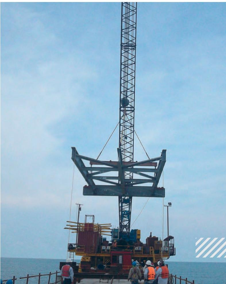
**Los pilotes se recibieron en tramos de 12 metros. En obra se hicieron las soldaduras de los diferentes tramos para conformar pilotes con longitudes entre 24 metros y 36 metros.**
