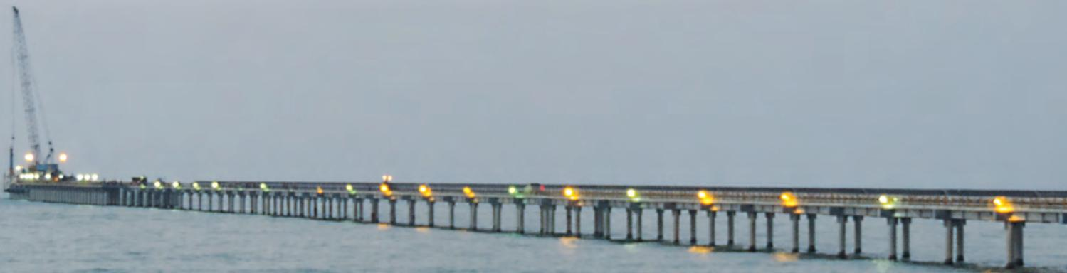
Esta viga lanzadora se desplazaba sobre la porción de estructura ya instalada logrando de esta forma tener una total independencia de las condiciones de oleajes y corrientes marinas presentes en la zona, lo que permitió tener rendimientos altos en la ejecución del proyecto.
