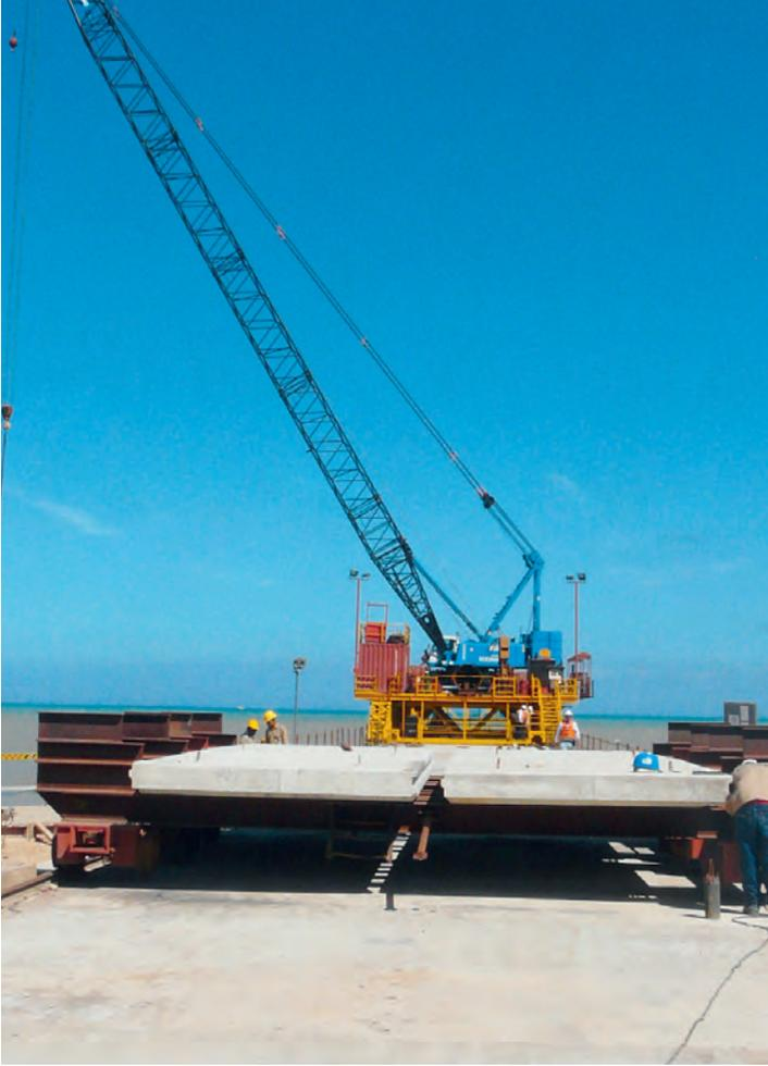
Todos los elementos que conforman la estructura del viaducto y del muelle fueron transportados desde la zona de la costa hasta los frentes de trabajo por medio de unos carros tipo vagón que circulaban sobre unos rieles metálicos instalados sobre las placas de concreto.
