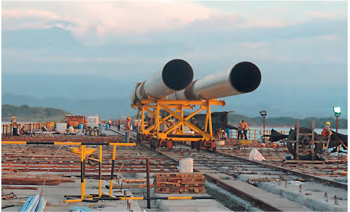
**El montaje correspondiente al viaducto acceso y del muelle principal tomó 22 meses. La estructura se basa en pórticos conformados por pilotes tubulares metálicos y vigas cabezales también metálicas tipo cajón con separaciones de 20 metros.**
