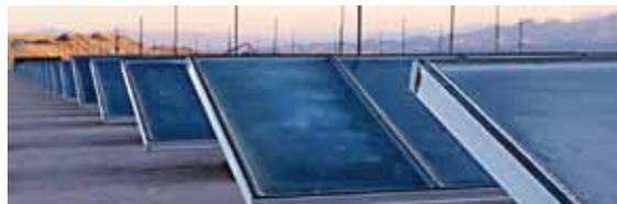
Los paneles solares tienen una dimensión total de 15 m<sup>2</sup>, compuestos de aluminio, cobre, lana mineral que actúa como aislante y vidrio súper resistente a golpes y cambios de temperatura.
