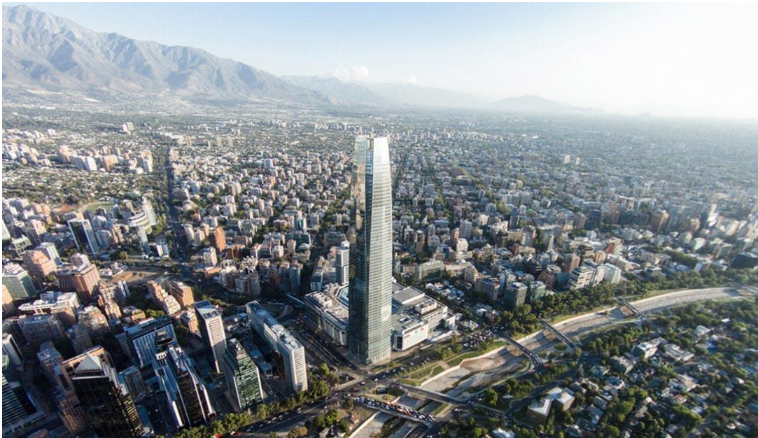
Imagen: Contexto urbano mall Costanera Center. Fuente: www.mall.costaneracenter.cl/sky
