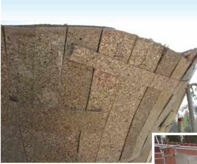
LOS MOLDAJES SE CONSTITUYEN A TRAVÉS DE PLACAS CONFORMADAS DE PLÁSTICO Y ALUMINIO.
