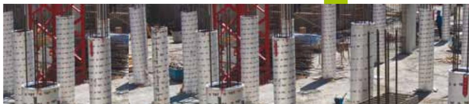
A PARTIR DEL RECICLAJE DE ENVASES DE CARTÓN SE FABRICAN LÁMINAS LISAS DE 1,22 M X 2,44 M CON UN ESPESOR DE 6 MM Y LÁMINAS ACANALADAS DE 1 M X 2,44 METROS.
