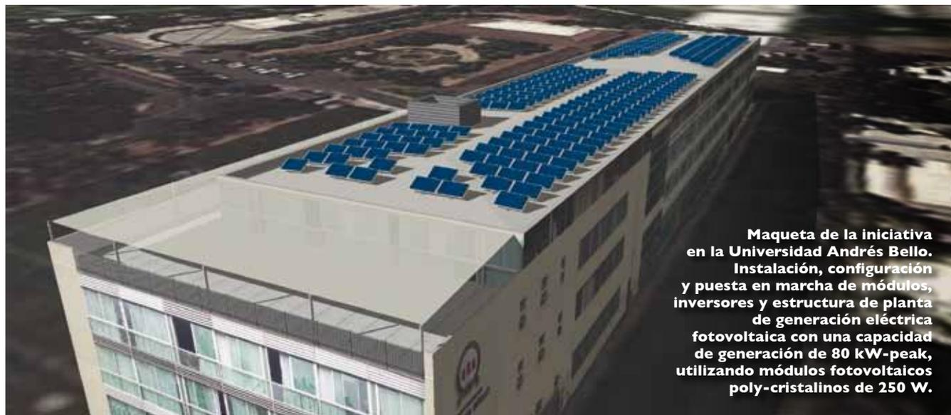
**Maqueta de la iniciativa en la Universidad Andrés Bello. Instalación, configuración y puesta en marcha de módulos, inversores y estructura de planta de generación eléctrica fotovoltaica con una capacidad de generación de 80 kW-peak, utilizando módulos fotovoltaicos poly-cristalinos de 250 W.**
