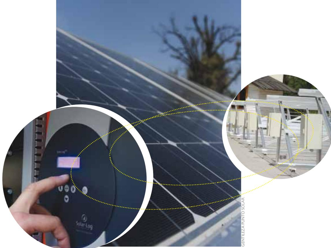
El proyecto fotovoltaico de la universidad, cuenta con un instrumento de captura y almacenaje de datos (DataLogger), como energía producida y potencia que suministra el sistema.
