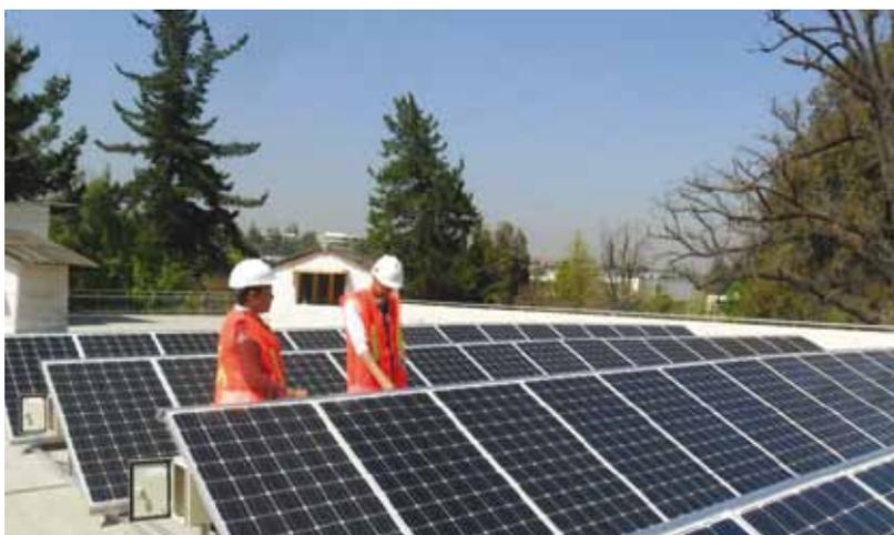
Gracias a estos paneles de 195 Wp, la energía solar se transforma en eléctrica. En el proyecto de la UNAB, son 90 placas solares en total.
