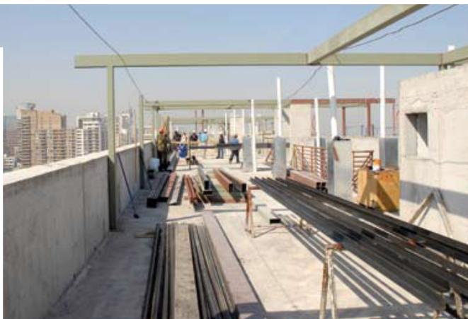
**La iniciativa demandó el diseño y construcción de una estructura metálica que cruza la azotea del edificio.**
