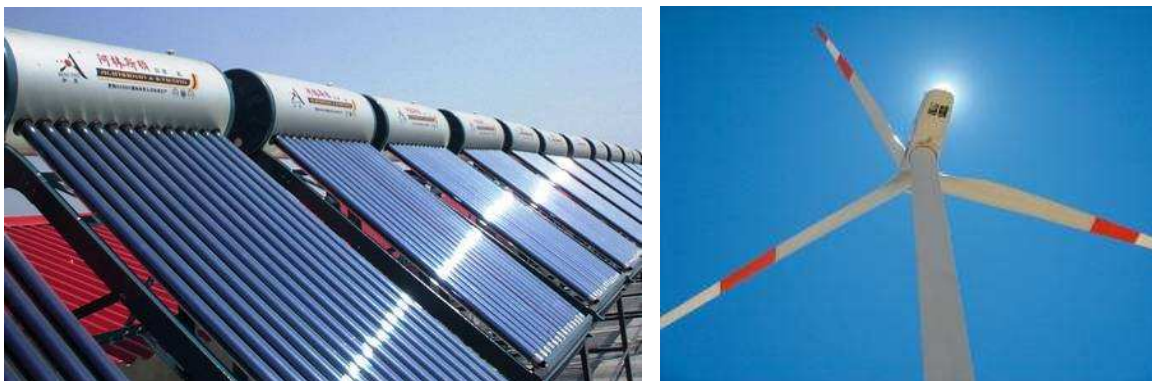
Figura N° 38 Colectores solares térmicos para agua caliente residencial, generación eléctrica eólica
