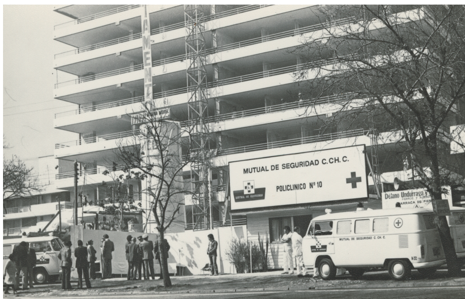
Inauguración de policlínico en obra, 1979.
