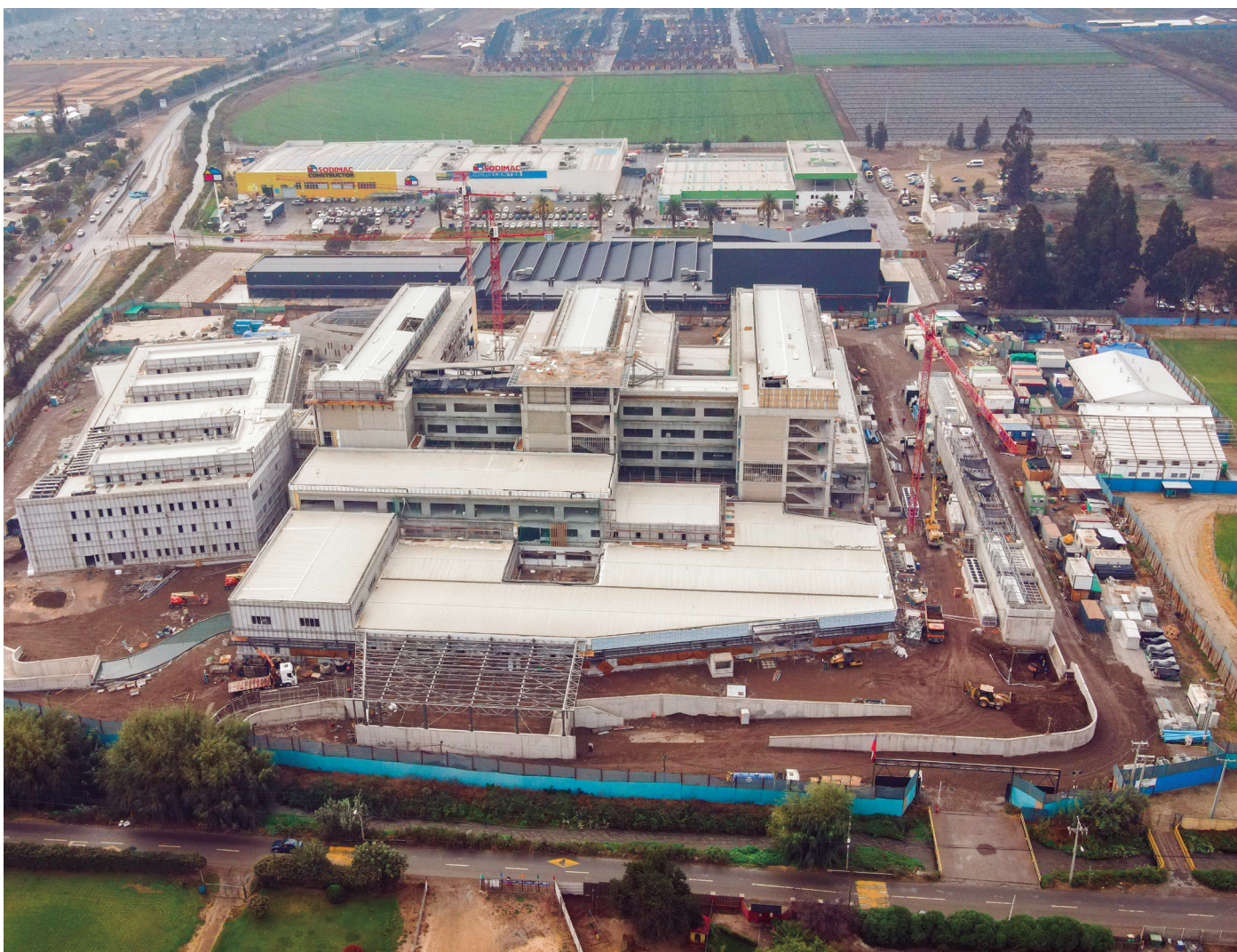
La edificación del hospital se inició en noviembre de 2018 y alcanza el 56% de avance.
