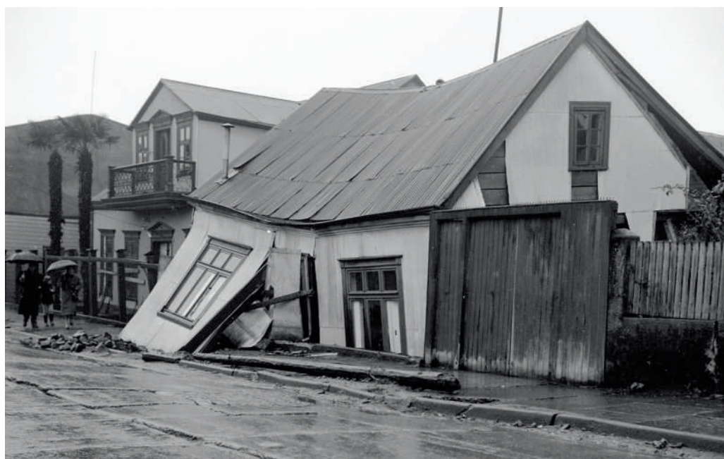
Derrumbe de una estructura tras el terremoto de 1960. Fachada de un recinto en Valdivia, durante su demolición tirándola con una cuerda tras el terremoto de 1960. Fotógrafo Jack Ceitelis.
