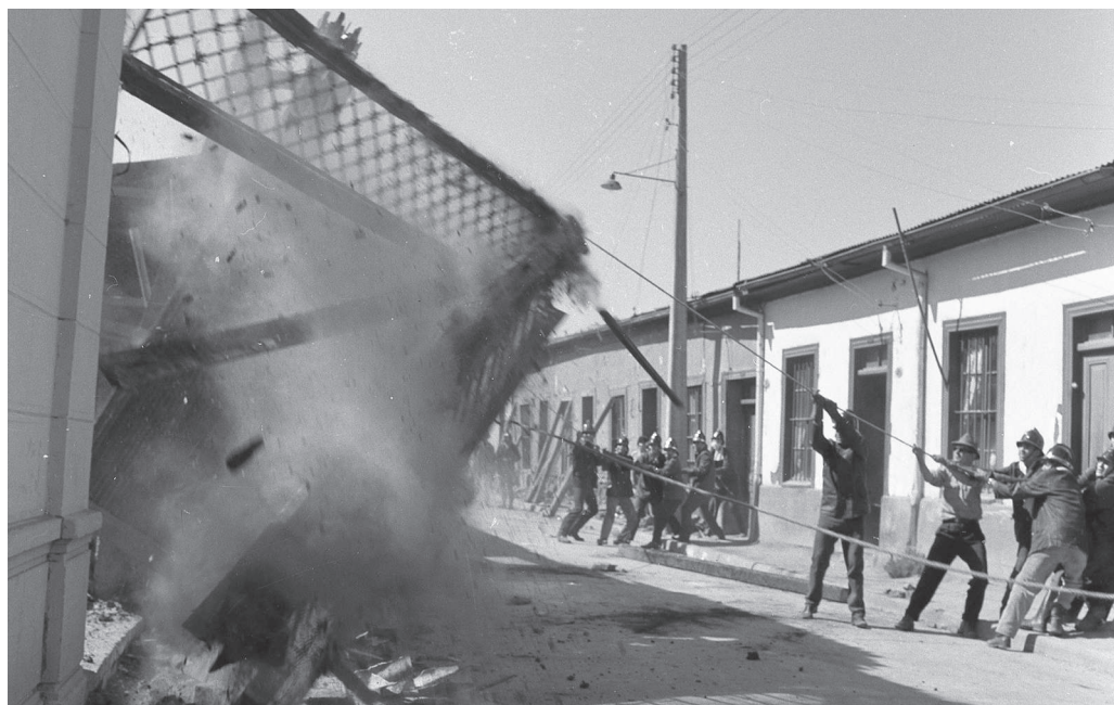
Demolición de una estructura tras el terremoto de 1960. Imagen de un grupo de bomberos derribando con cuerdas la fachada de una construcción tras el terremoto de 1960. Fotógrafo Jack Ceitelis.
