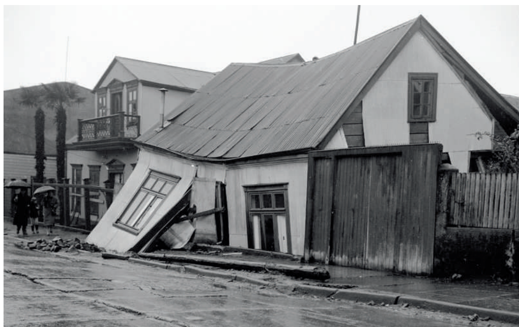
Derrumbe de una estructura tras el terremoto de 1960. Fachada de un recinto en Valdivia, durante su demolición tirándola con una cuerda tras el terremoto de 1960. Fotógrafo Jack Ceitelis.
