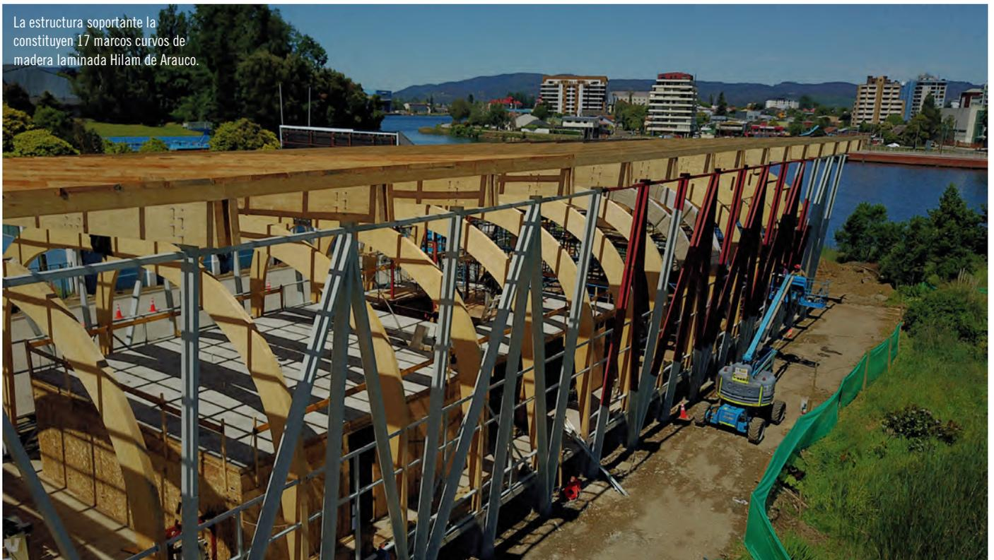
norte y sur, que se caracteriza por sus diagonales. Cuando esté terminado, desde el exterior se verán solo vidrio y madera, ya que los elementos de acero serán revestidos con madera termotratada.
