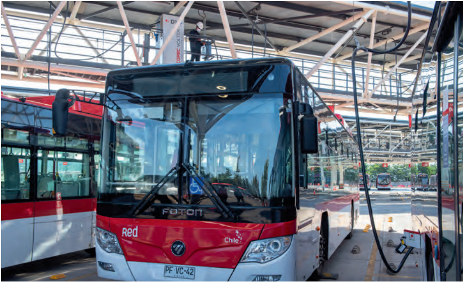
Un total de 215 buses eléctricos se abastecen en este rodoviario cero emisiones.
