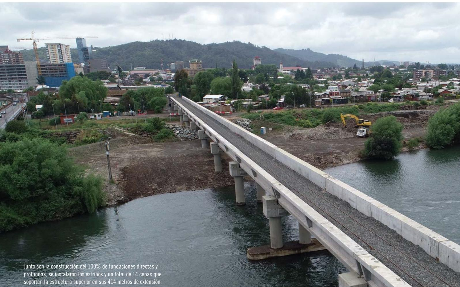
Junto con la construcción del 100% de fundaciones directas y profundas, se instalaron los estribos y un total de 14 cepas que soportan la estructura superior en sus 414 metros de extensión.
