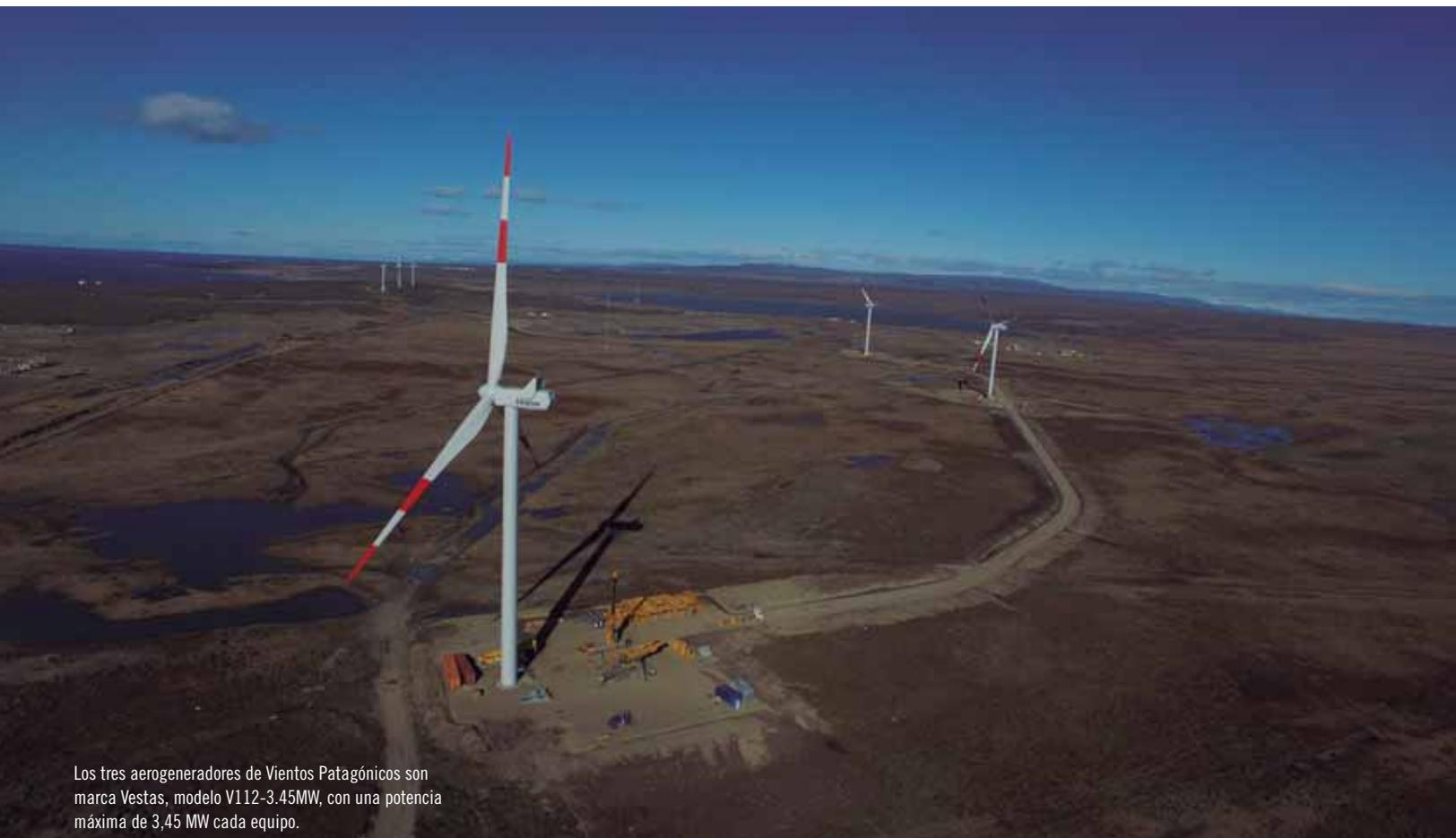
Los tres aerogeneradores de Vientos Patagónicos son marca Vestas, modelo V112-3.45MW, con una potencia máxima de 3,45 MW cada equipo.
