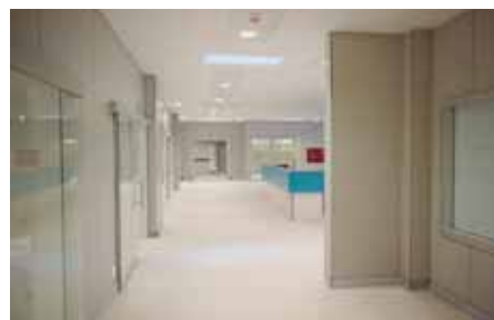
Terminaciones interiores y la configuración del sistema de control centralizado son parte de los trabajos finales.
