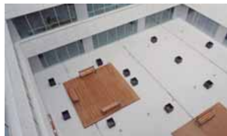
Patios interiores que sirven como áreas de descanso le dan calidez a la construcción.
