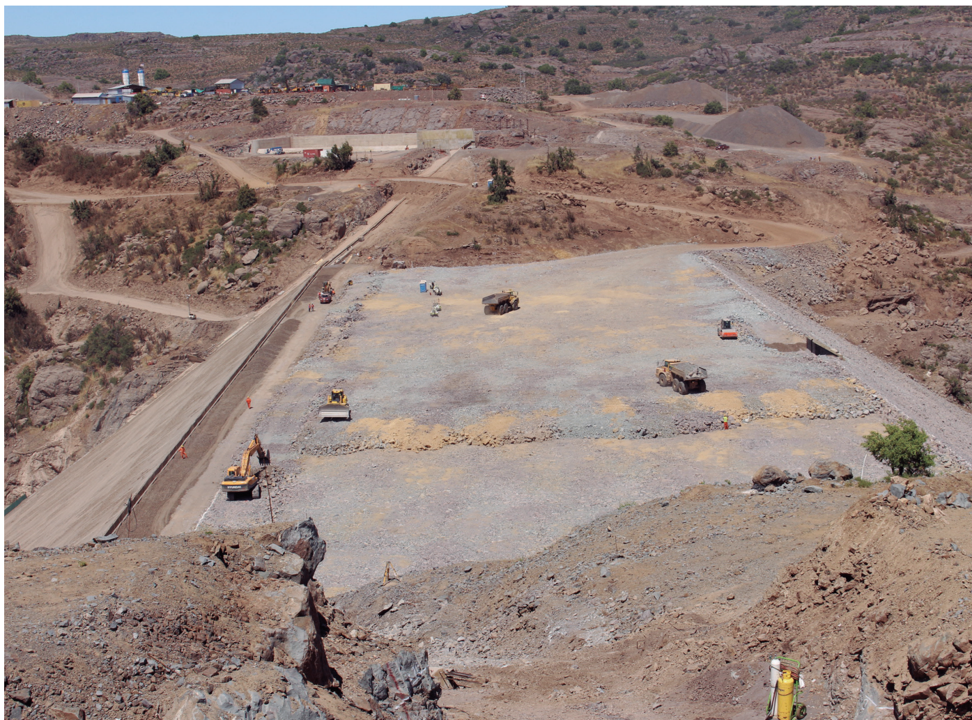
Construcción de obras anexas. Entre ellas destacan una ruta asfaltada de 20 kilómetros, una línea eléctrica en media tensión de 13,2 KV y la oficina de operaciones.
