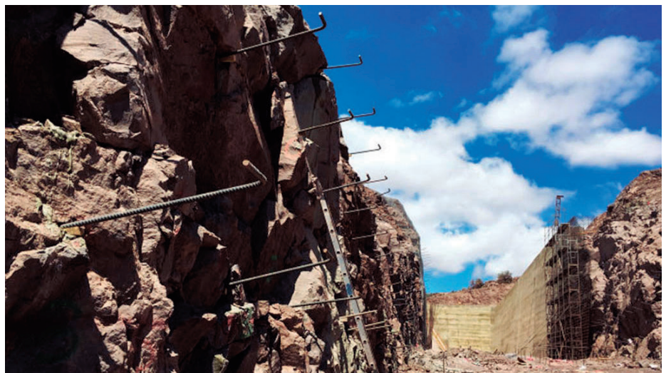
Las obras principales son el evacuador de crecidas y la infraestructura de desvío, descarga de fondo y entrega a riego.
