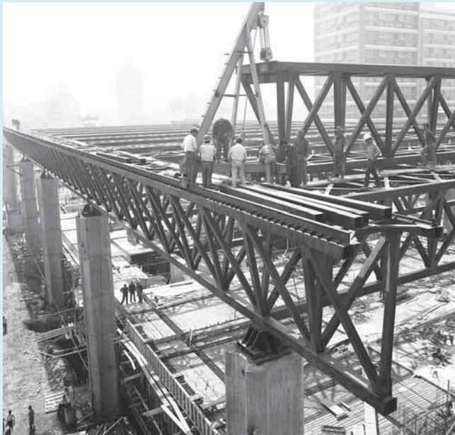
Imagen de la construcción de un techo de una de las alas del edificio UNCTAD III en Santiago. Foto Jack Ceitelis.
