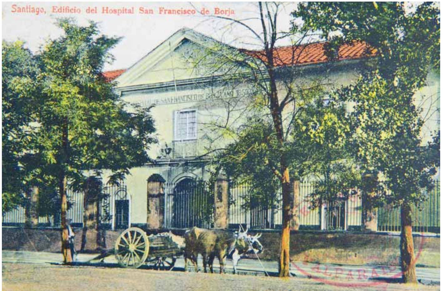
Segundo edificio del Hospital San Francisco de Borja, Santiago, Chile, sin fecha. Fachada del segundo edificio que tuvo el Hospital San Francisco de Borja, que se ubicaba en lo que hoy es la avenida Libertador Bernardo O'Higgins, entre Portugal y Vicuña Mackenna. Fotógrafo desconocido.
