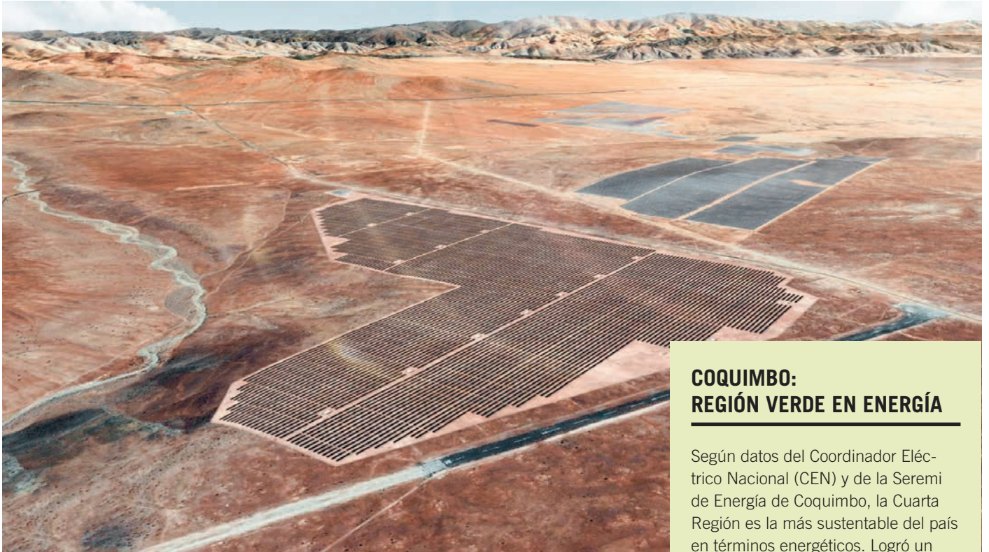
La superficie del parque solar será de 145 hectáreas.
