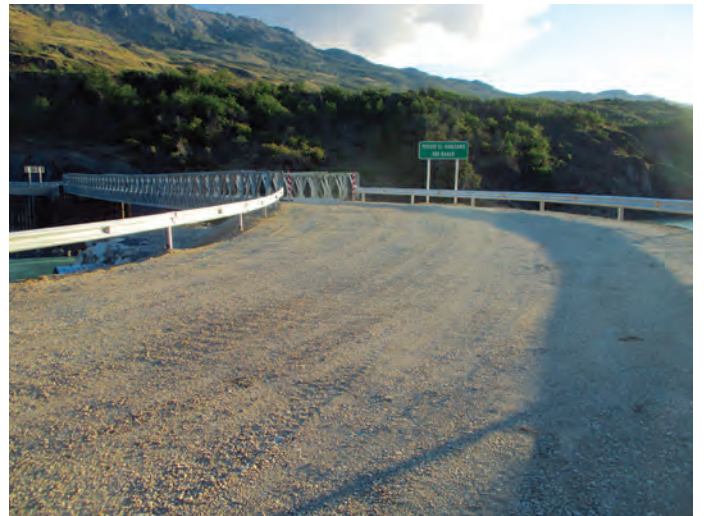
El puente El Mazano tiene 7,95 metros de longitud, un ancho de 3,20 metros y una capacidad para soportar 30 toneladas.
