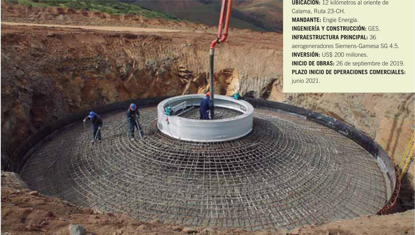
Se realizó un trabajo especial en las bases para elevar la altura de los aerogeneradores en cuatro metros para así aprovechar mejor el viento.
