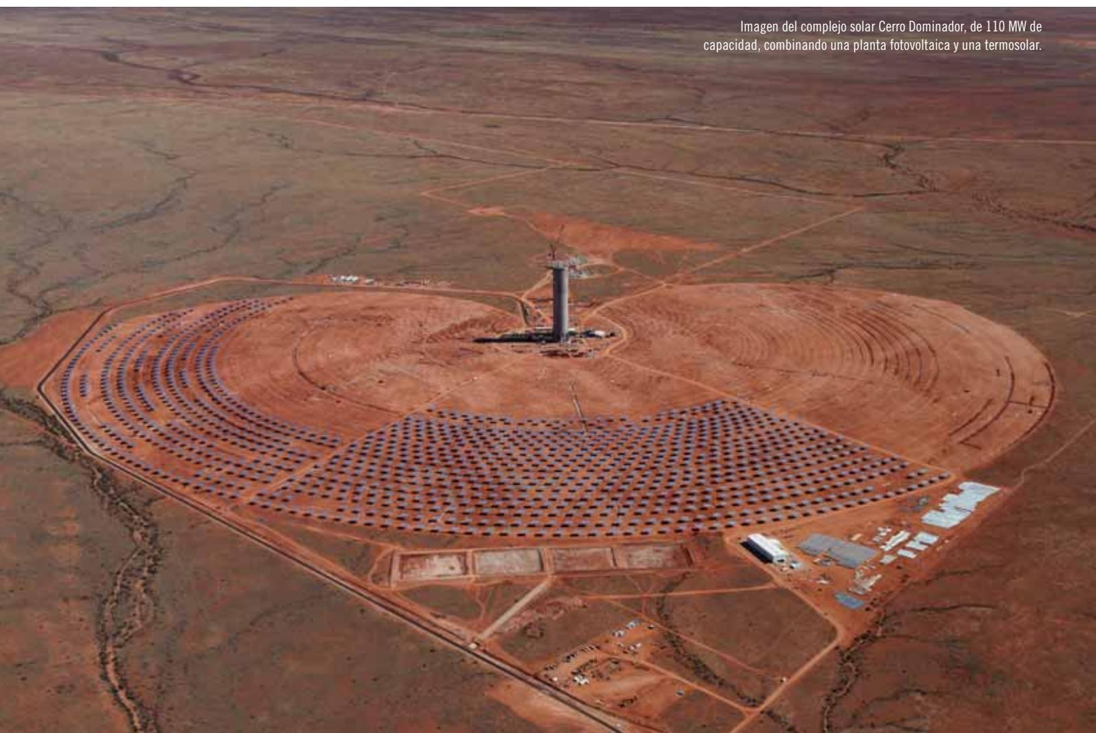
Imagen del complejo solar Cerro Dominador, de 110 MW de capacidad, combinando una planta fotovoltaica y una termosolar.
