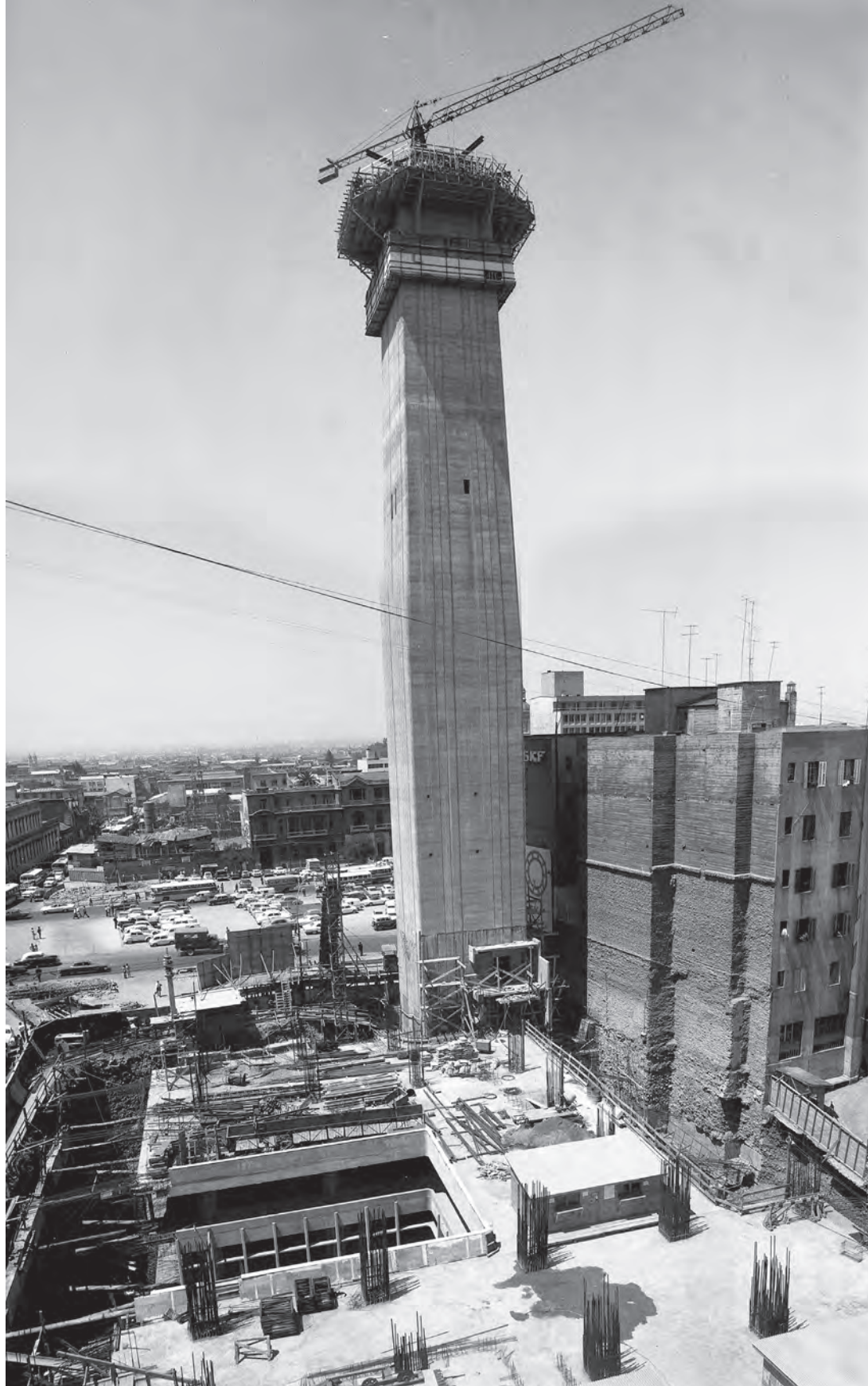
Construcción de la Torre Entel, 1972.
