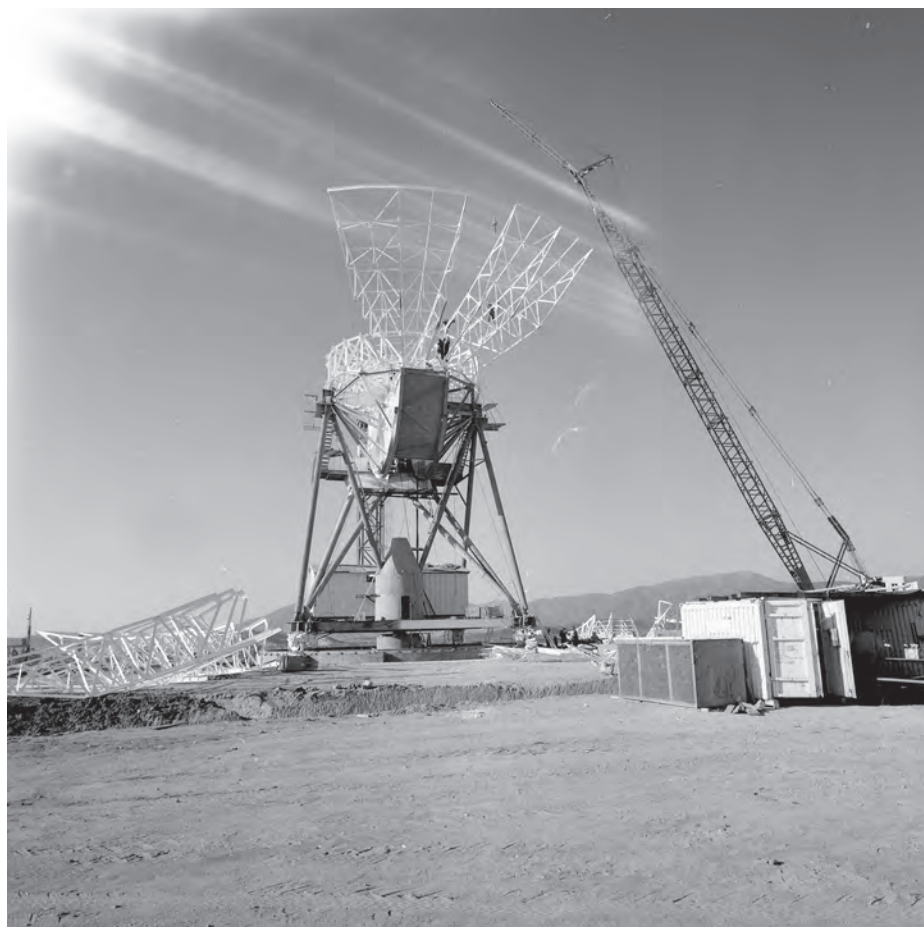
Construcción de una antena satelital, 1974.
