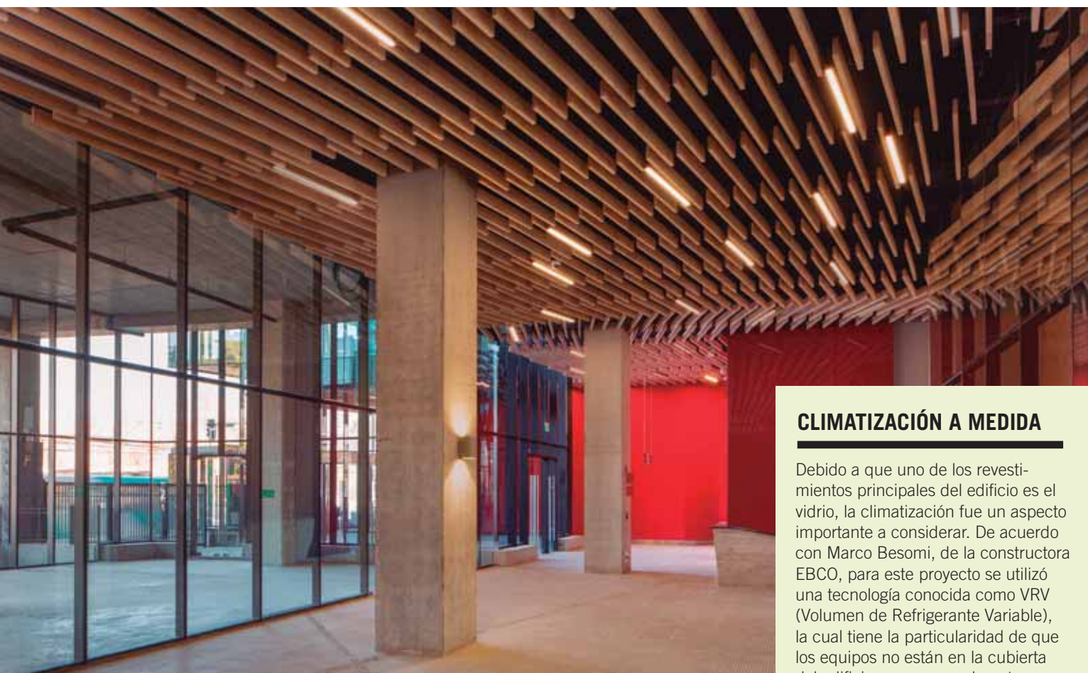
PITS Núcleo Bellavista cuenta con diez pisos y seis subterráneos. El -1 contiene locales comerciales, un restaurante y una sala de teatro.
