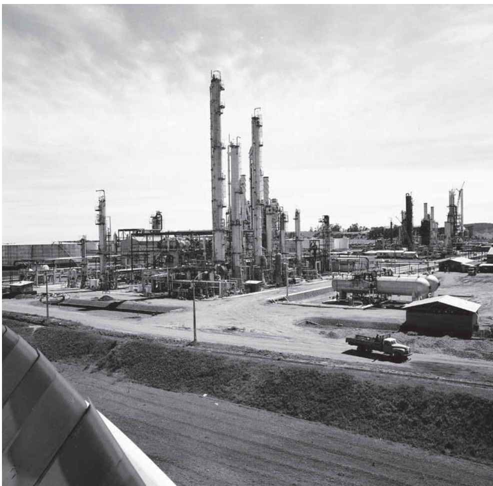
Construcción de la refinera Petrox en Hualpén, 1971. Imagen general de la refinera Petrox (actual refinera Bio Bio) en Hualpén, Región del Bio Bio, durante su construcción. Fotógrafo Jack Ceitelis.
