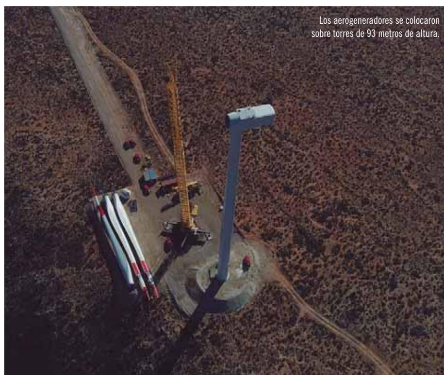
Los aerogeneradores se colocaron sobre torres de 93 metros de altura.
