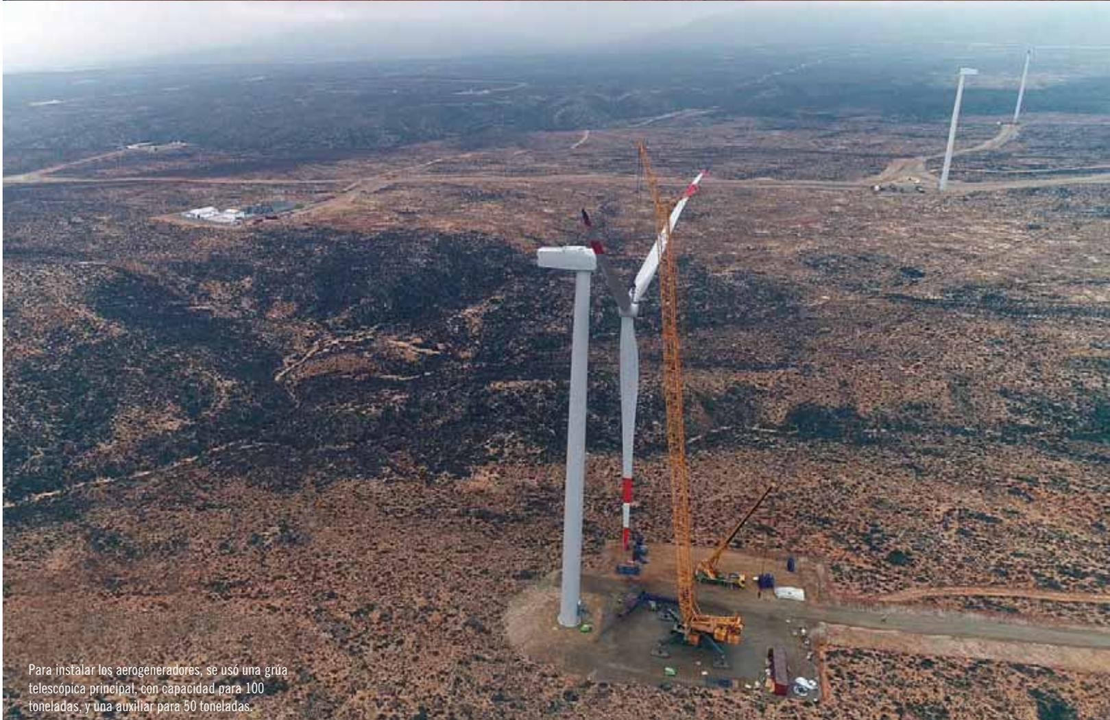
Para instalar los aerogeneradores, se usó una grúa telescópica principal, con capacidad para 100 toneladas, y una auxiliar para 50 toneladas.
