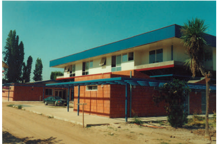
Imagen general de la fachada de la Clínica Familia recién inaugurada, destinada inicialmente a personas con VIH/Sida. 1997. Fotógrafo Desconocido.
