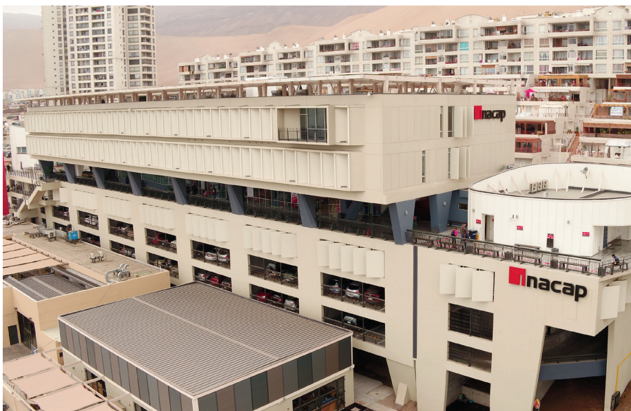
Los niveles 1 y 2, que miran hacia avenida La Tirana, albergan los estacionamientos.
