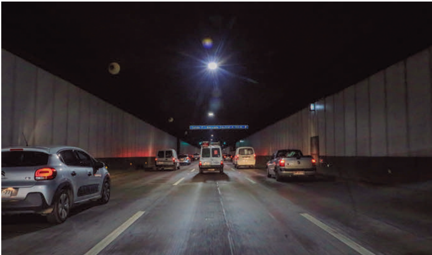
Si se le traspasara al Fondo de Infraestructura el valor residual de todas las actuales concesiones de carreteras, tendría entre US$ 8 mil y 15 mil millones. En la foto, la Costanera Norte.
