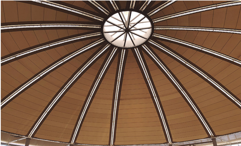
La cúpula consiste en una cubierta liviana de forma lenticular, elaborada con una doble capa de PVC translúcido.
