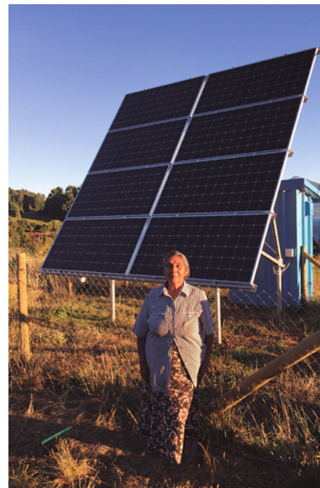
En 151 casas en Isla Huapi, Lago Ranco, se instalaron este año paneles solares de 2,7 kW con baterías de 24 kWh.
