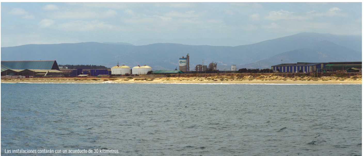
La planta desaladora se ubicará en el Fundo El Carrizo, en el sector costero de la comuna de Puchuncaví.
