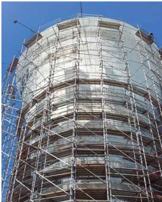
Torre de agua de Rancagua.
