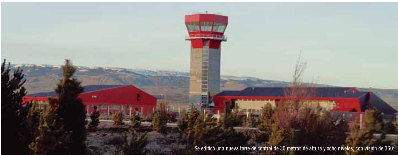
Se edificó una nueva torre de control de 30 metros de altura y ocho niveles, con visión de 360°.
